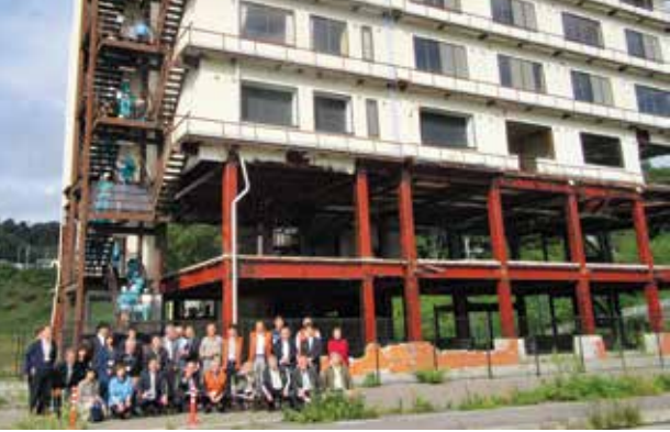
田老地区震災遺構
